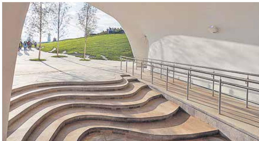
Сложные криволинейные конструкции «Ледяной пещеры» в парке «Зарядье» выполнены с применением стеклофибробетона
