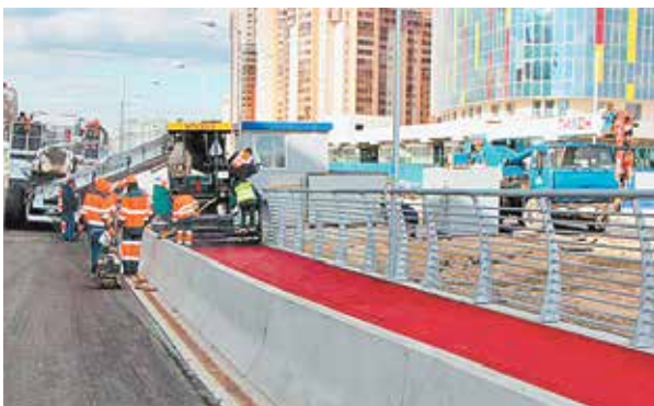
Работы по укладке красного асфальта на велодорожке в Петербурге
